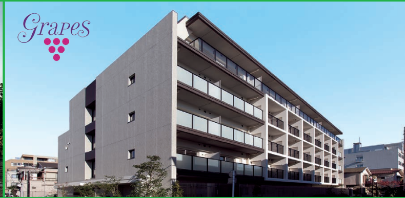
グレイプス大森西 / 東京都大田区、2014年12月竣工
