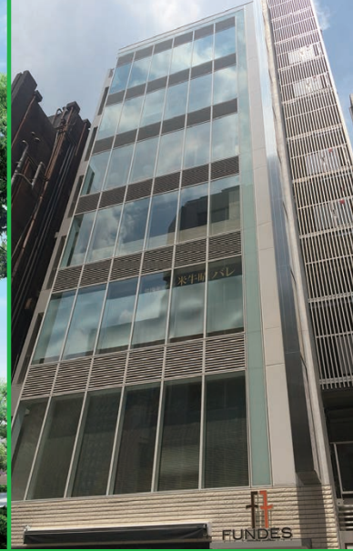
FUNDES水道橋 / 東京都千代田区、2015年7月竣工
