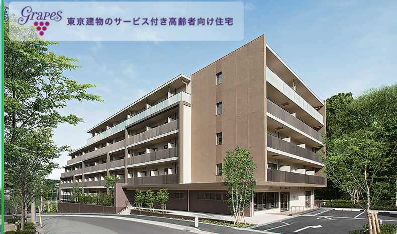
グレイプスフェリシティ戸塚 / 横浜市、2015年1月竣工
