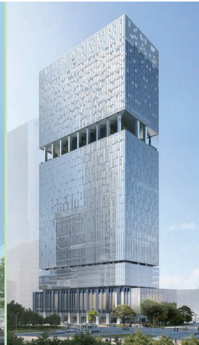
CPFビル再開発プロジェクト ／シンガポール、2020年竣工予定
