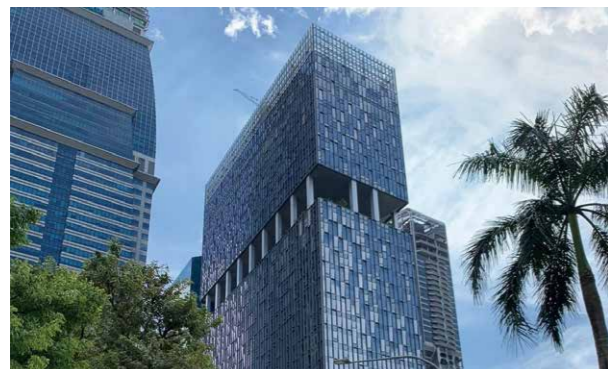
79 ロビンソンロード (CPFビル再開発PJ)
