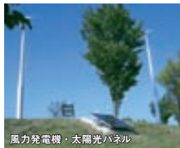
風力発電機・太陽光パネル
