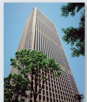
新宿センタービル外観
