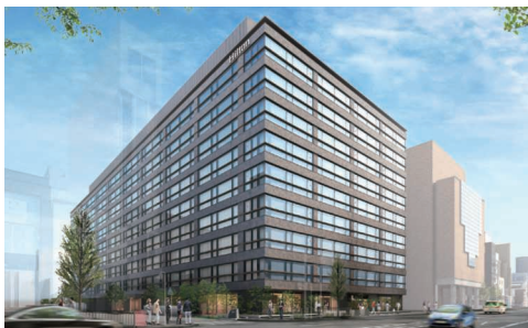
ヒルトン京都 ／京都市中京区、2024年竣工予定
