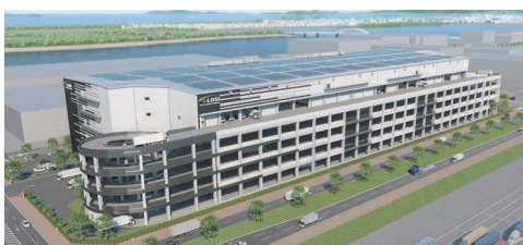
T-LOGI福岡アイランドシティ ／福岡市東区、2024年竣工予定
