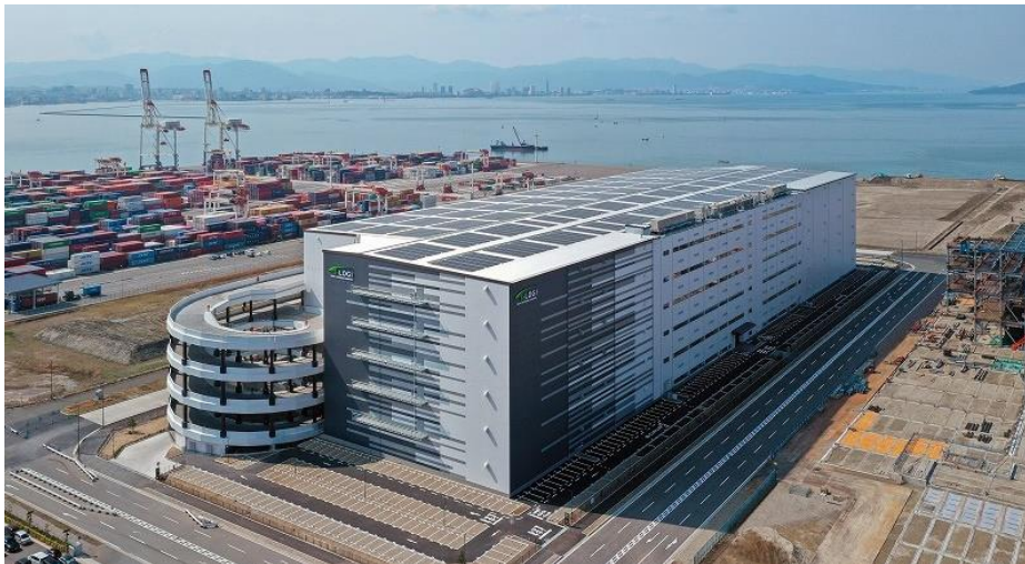
「T-LOGI 福岡アイランドシティ」外観
