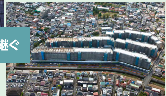
建設中の「Brillia City 石神井公園 ATLAS」(上空から見た現地の様子)
